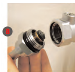
Dévissez la partie antérieure de la clef puis changez le mécanisme et revissez là.
