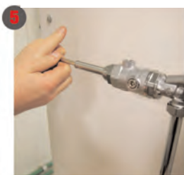
Après avoir vissé la clef, enfoncez la tige en la vissant jusqu'à la prise du mécanisme à l'aide d'une clef à lène.
