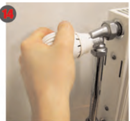
Puis remettez le volant manuel ou placez une tête thermostatique.
